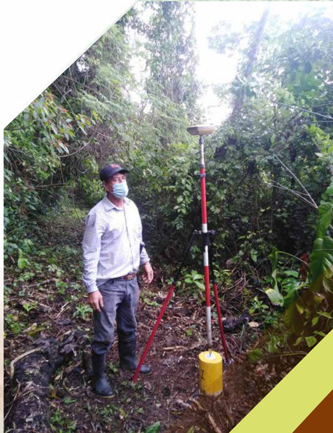
► Técnico de demarcación, en la colocación de uno de los mojones.
