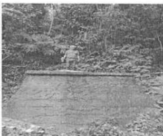
Tanque de captación de depósito de agua
