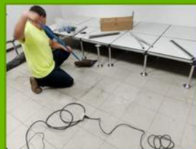
Instalación de "Piso Elevado Técnico para Centro de Datos"
